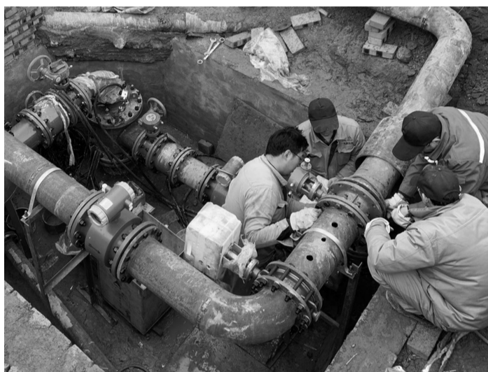
近日,陕西省一四四煤田地质局承担施工的陕西眉县县城清洁能源供暖系统建设项目地热井抽采回灌机电安装工程顺利完工,项目的建成和运行,进一步扩大了眉县县城冬季地热供暖面积。此次机电安装工程由一四四公司机械厂负责施工,施工期间,技术人员秉持“精益求精、质量为本”的理念,严格控制抽采回灌系统设计、施工、装配工艺等各个环节,凭借丰富的工程经验,在作业空间有限的条件下,攻克了漏水环境井口管道切割与井口装置安装等一系列技术难题,确保了工程任务高标准高质量圆满完成。 武佳欣 丁亮 摄影报道
