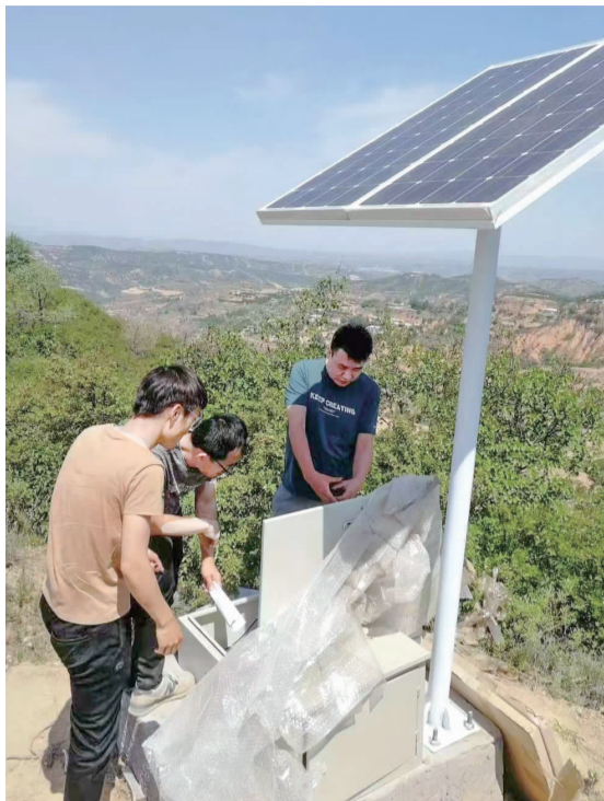
技术人员进行 监测主机维护和仪器电缆铺设
